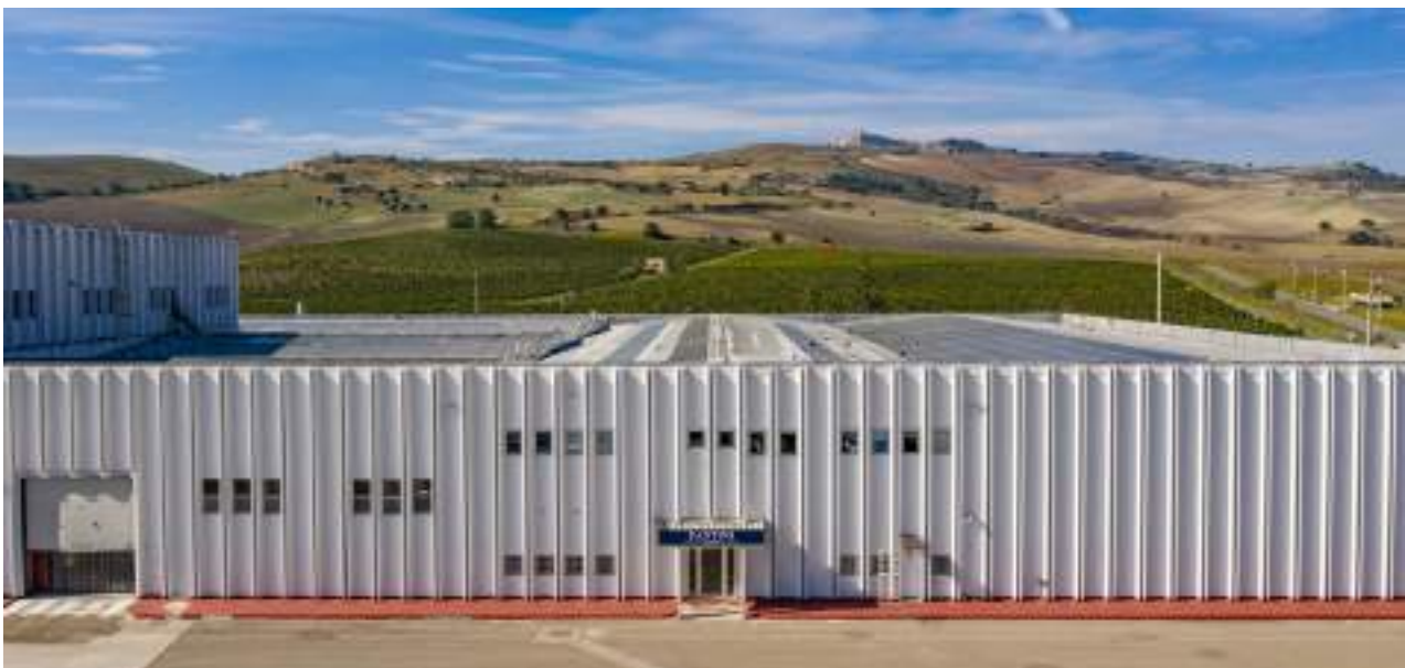
Stabilimento di Acerenza (PZ)
